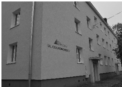
Termomodernizacja bloków mieszkalnych na Dźbowie
