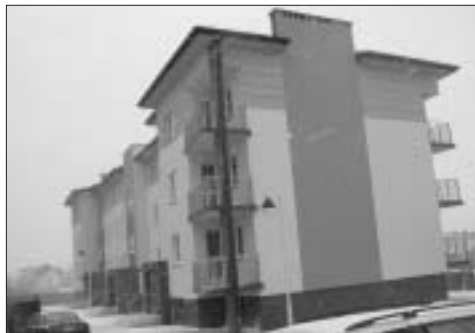
Nowy blok komunalny przy ul. Kontkiewicza 4a
