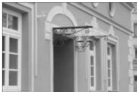
Plac Biegańskiego, budynek odwachu po remoncie, który zakończył się w 2004 roku
