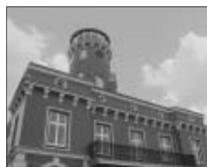
Wyremontowana elewacja Ratusza - listopad 2005 r.
