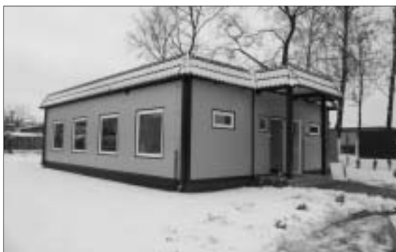
Nowozbudowany budynek ogrzewalni dla bezdomnych - ul. Krakowska 80
