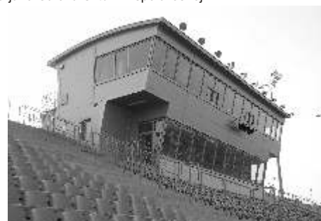
Stadion Miejski - nowa wieża sędziowska
