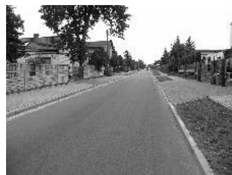
Wielkoborska, Koszalińska, Olsztyńska - to tylko niektóre z ulic z nową nawierzchnią i chodnikami
