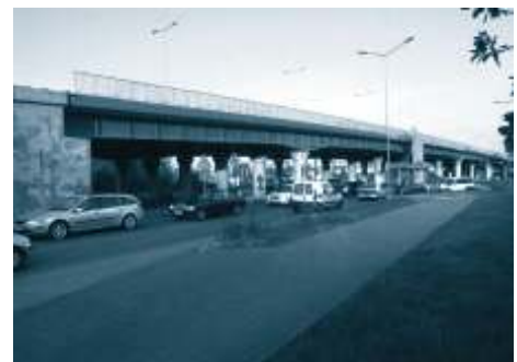
Wiadukt przy ul. Jagiellońskiej - największa inwestycja komunikacyjna 20-lecia
