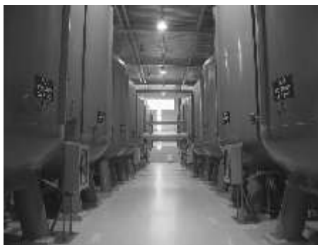
Stacja uzdatniania wody w Wierchowisku
