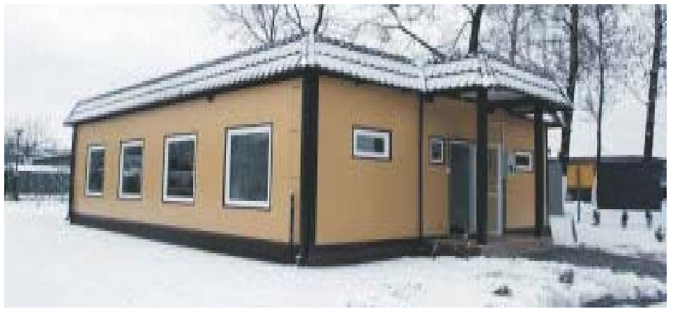
Budynek ogrzewalni przy ul. Krakowskiej 80/15
