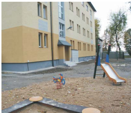
Blok z mieszkaniami komunalnymi, ul. Biurowa 1
