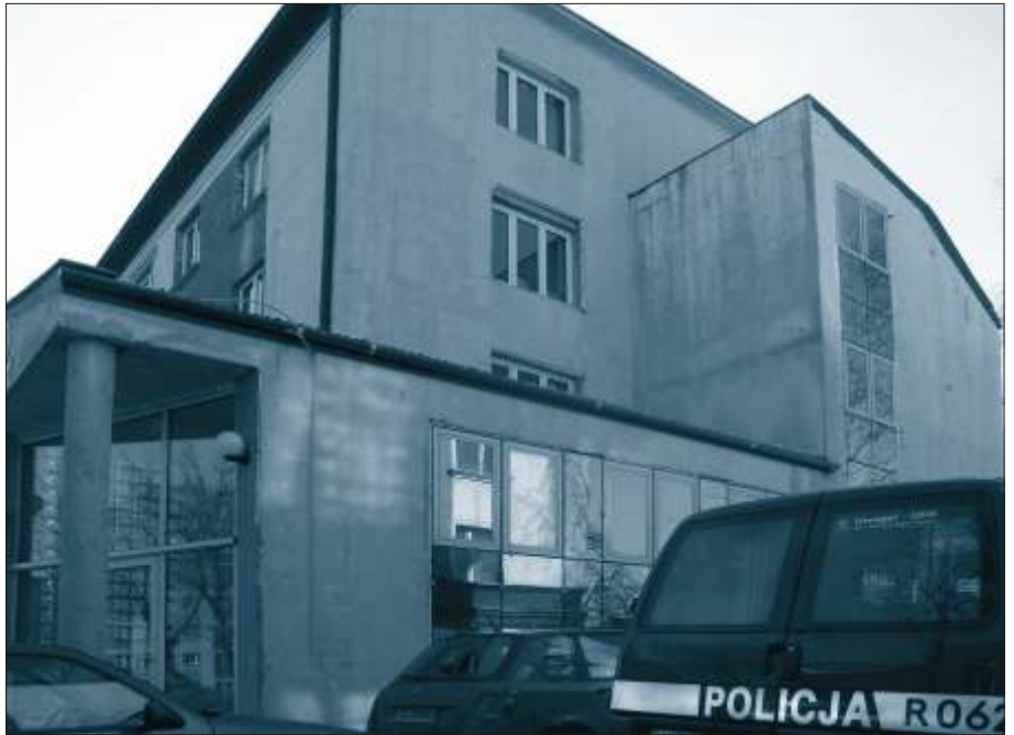
Wyremontowany budynek komisariatu przy ul. Łukasieńskiego
