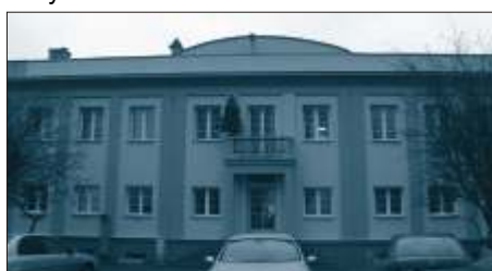
Budynek klubowy „Rakowa” po remoncie
