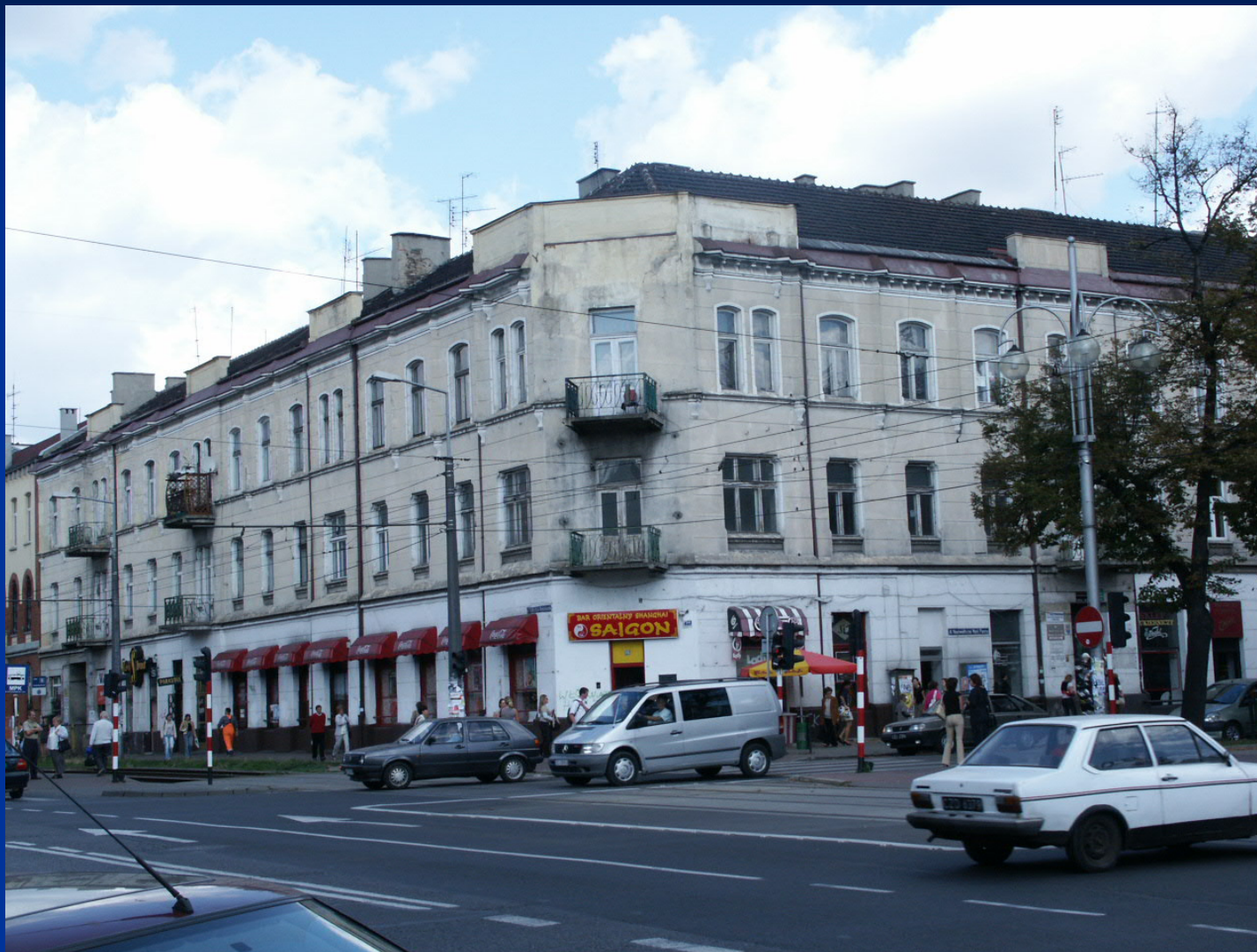
kamienica przy Alei Najświętszej Maryi Panny 24 - przed remontem
