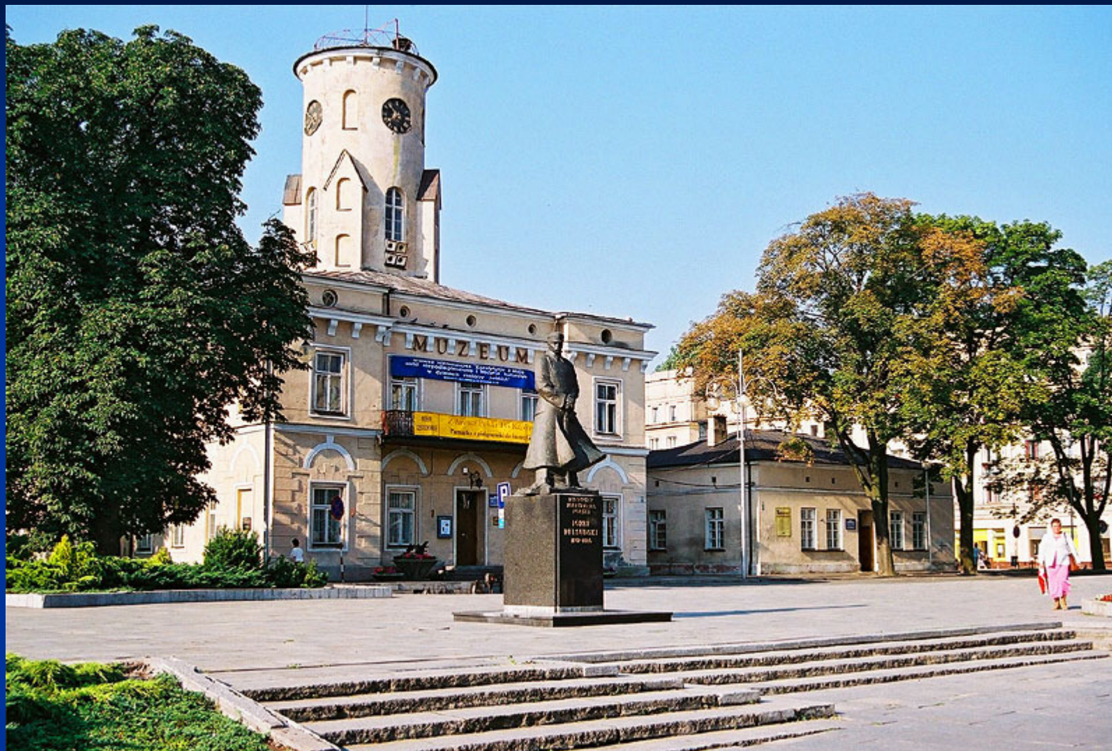
Ratusz Miejski i Odwach przed remontem
