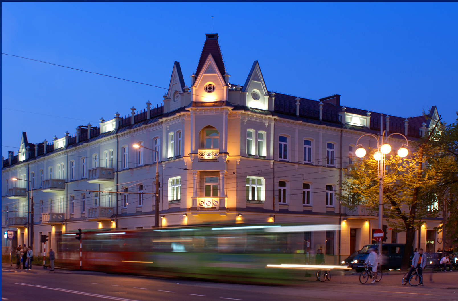
kamienica przy Alei Najświętszej Maryi Panny 24 - przed remontem
